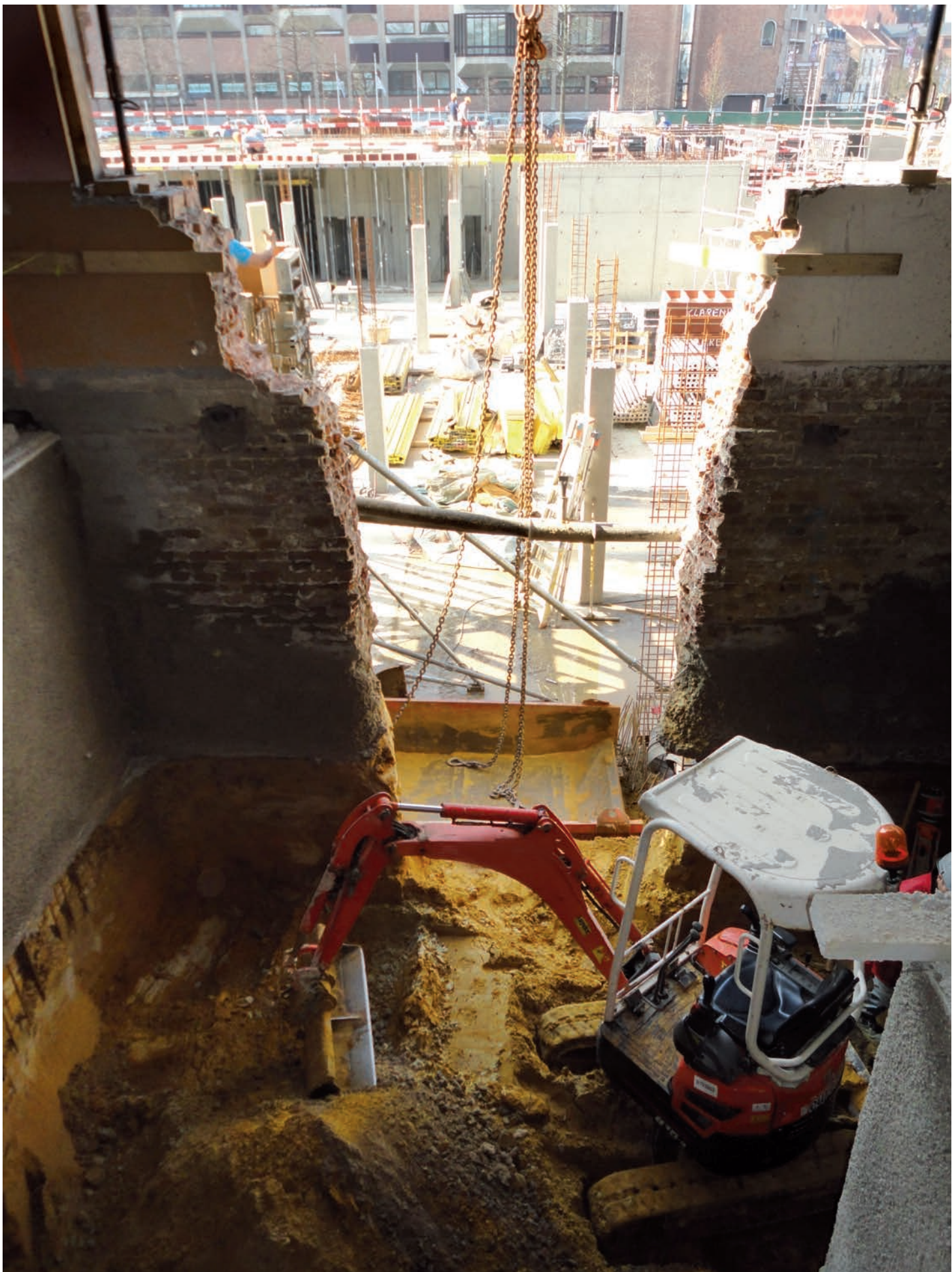
doorbraak verbindingsgang
