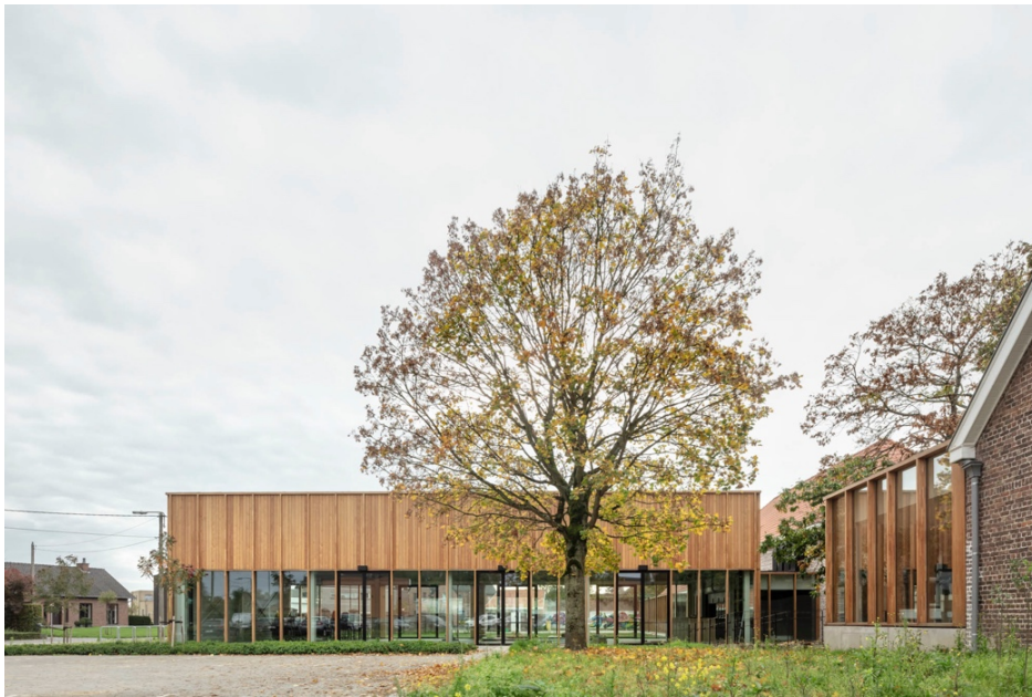
Die zweigeschossige Halle bietet Platz für 250 Personen. © Stijn Bollaert
